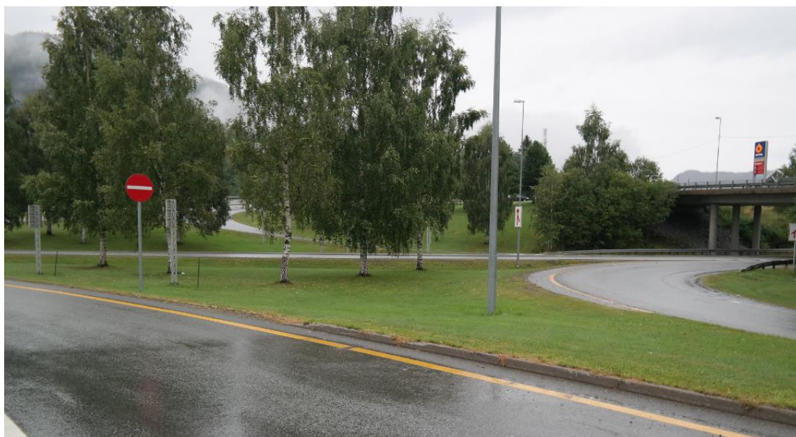
Figur 20: I Prestteigenkrysset, ramper øst for E6.
