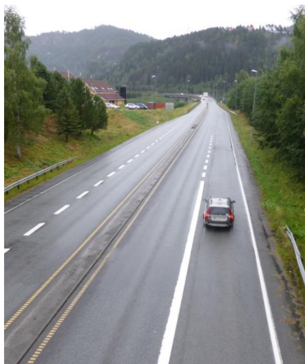
Figur 19: På E6 gjennom Prestteigenkrysset og nordover.
