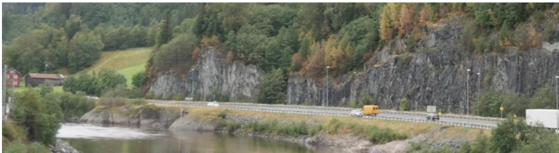
Figur 31: Eksisterende E6 mellom Håggåbrua og Rostad. Ny E6 kommer gjennom tunet på Rostad; til venstre i bildet.
